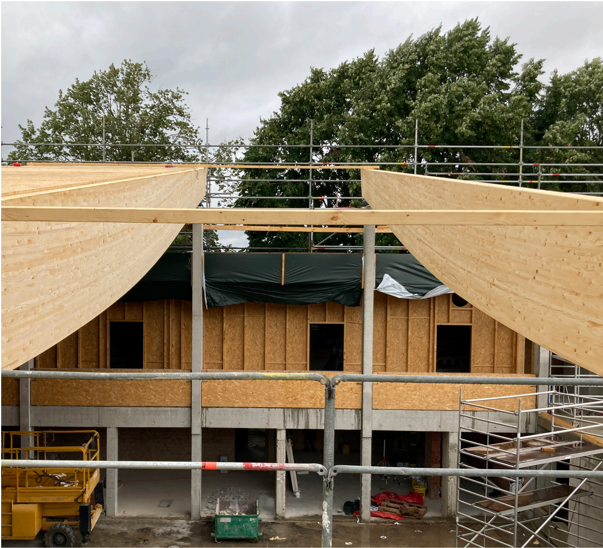
Bauabschnitt 2_Aufrichten BSH-Hallenrahmen und Hallendach Detail Anschluss BSH-Stütze an Stb.-Sockel
