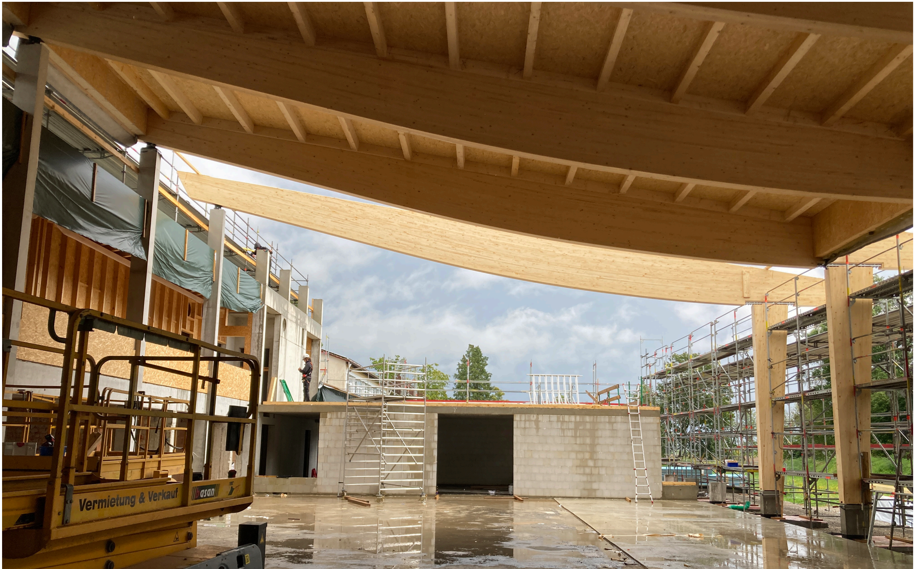
Bauabschnitt 2_Aufrichten BSH-Hallenrahmen und Hallendach
