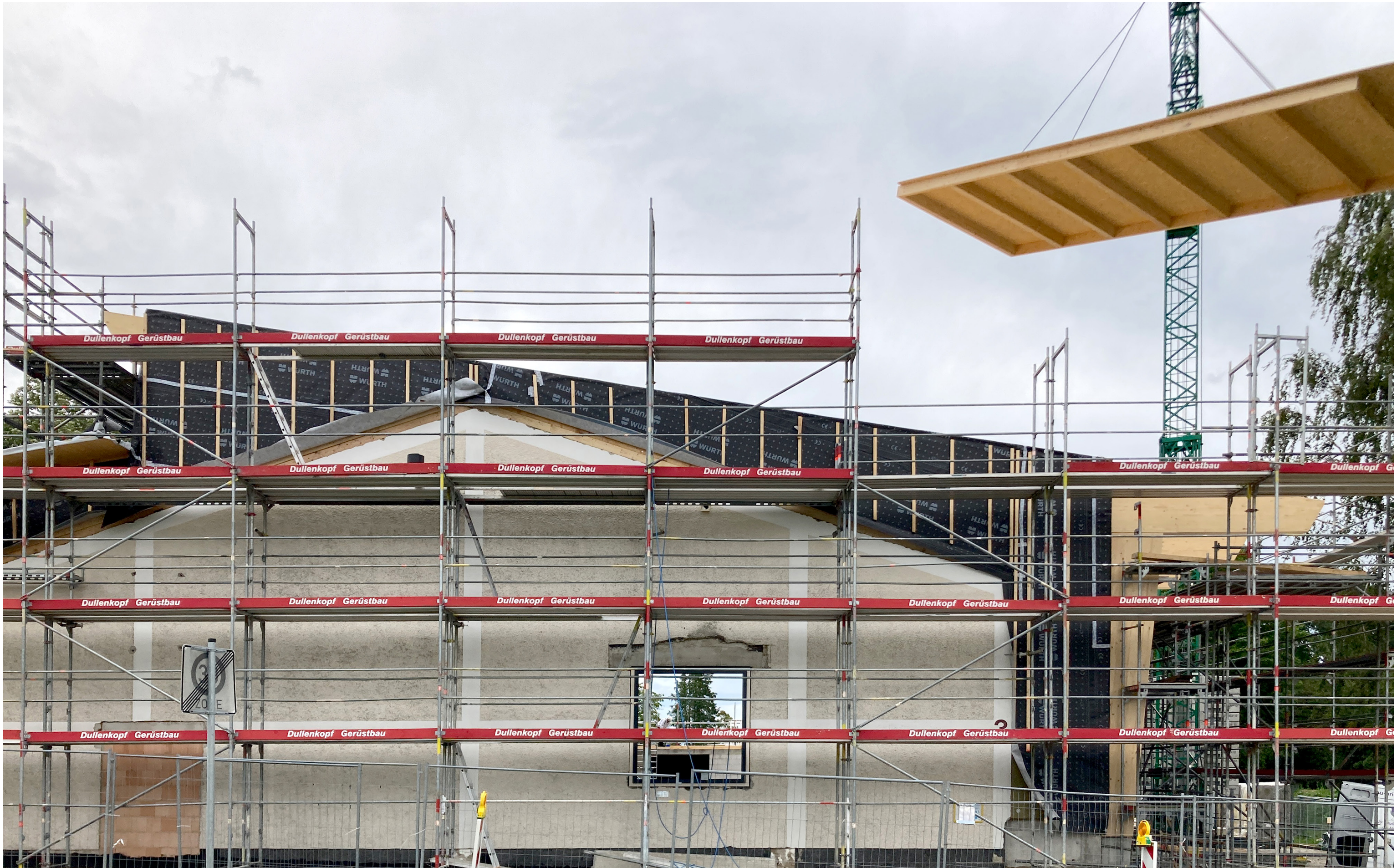
Bauabschnitt 2_Aufrichten BSH-Hallenrahmen und Hallendach
