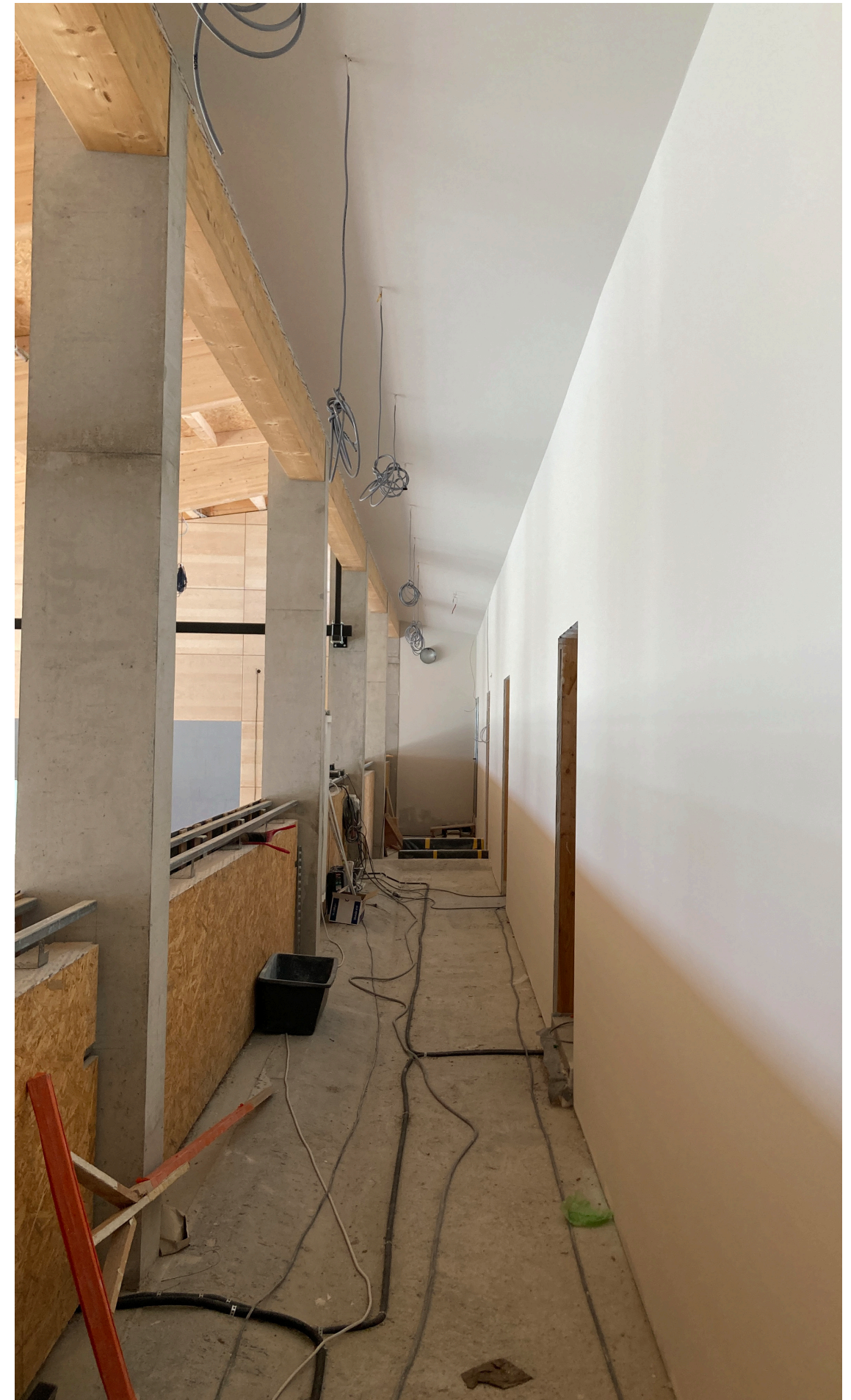
Baustelle Stand Innenausbau, Installationen
