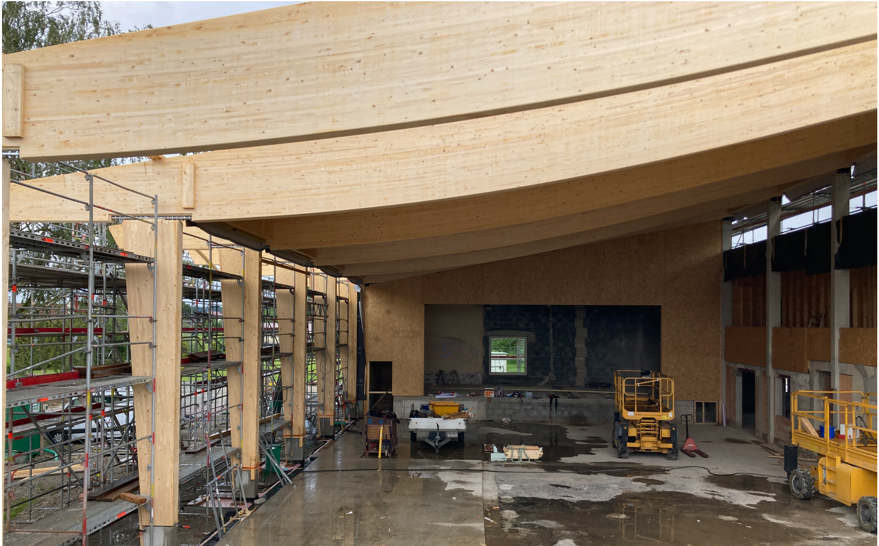
Bauabschnitt 2_Aufrichten BSH-Hallenrahmen und Hallendach
