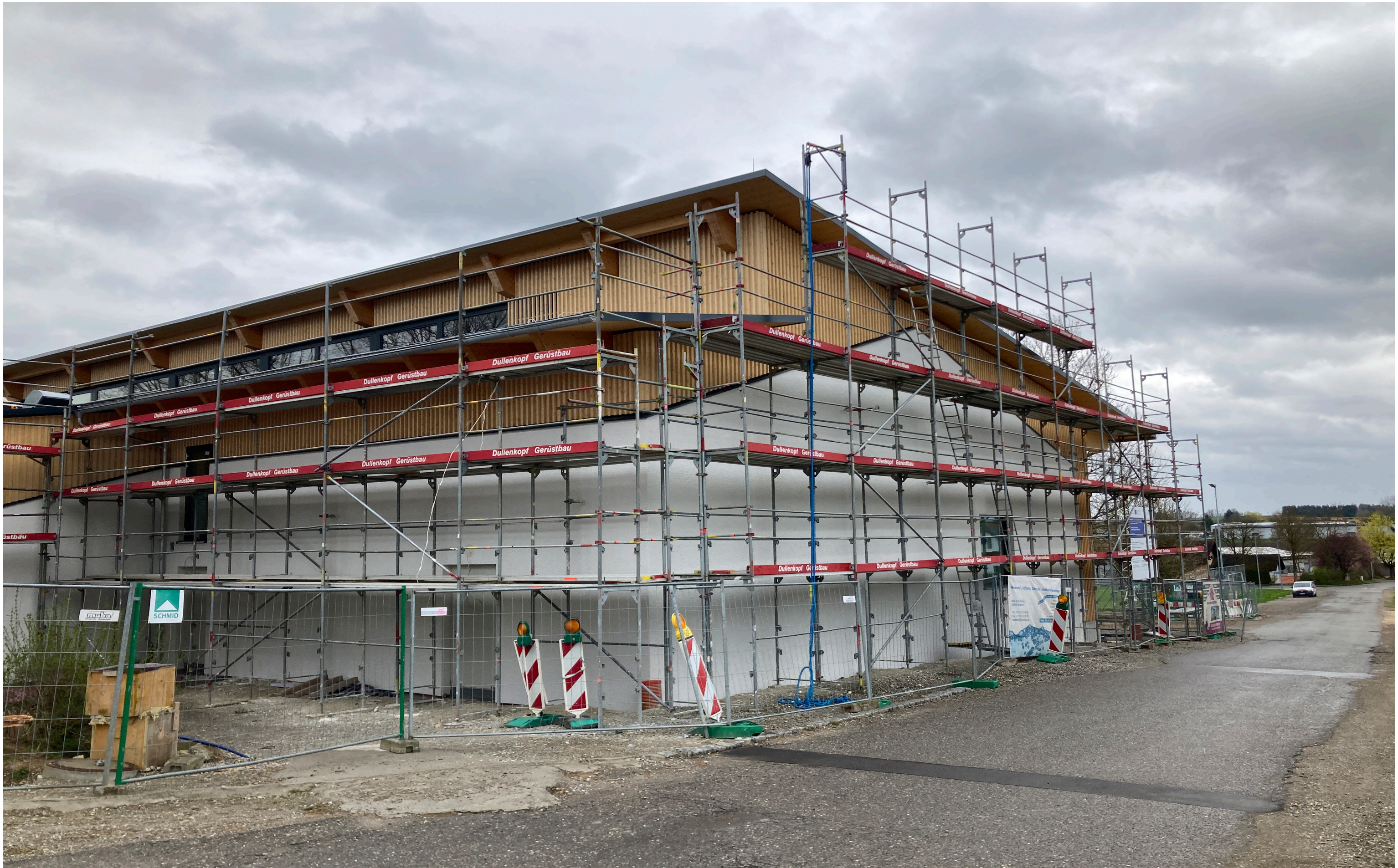
Abschluss Holz- und Putzfassade
