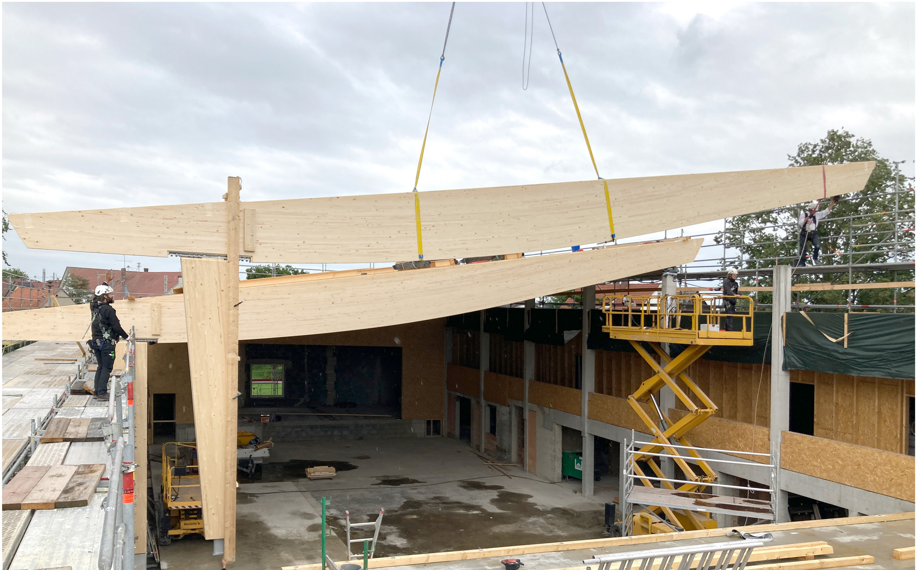
Bauabschnitt 2_Aufrichten BSH-Hallenrahmen und Hallendach
