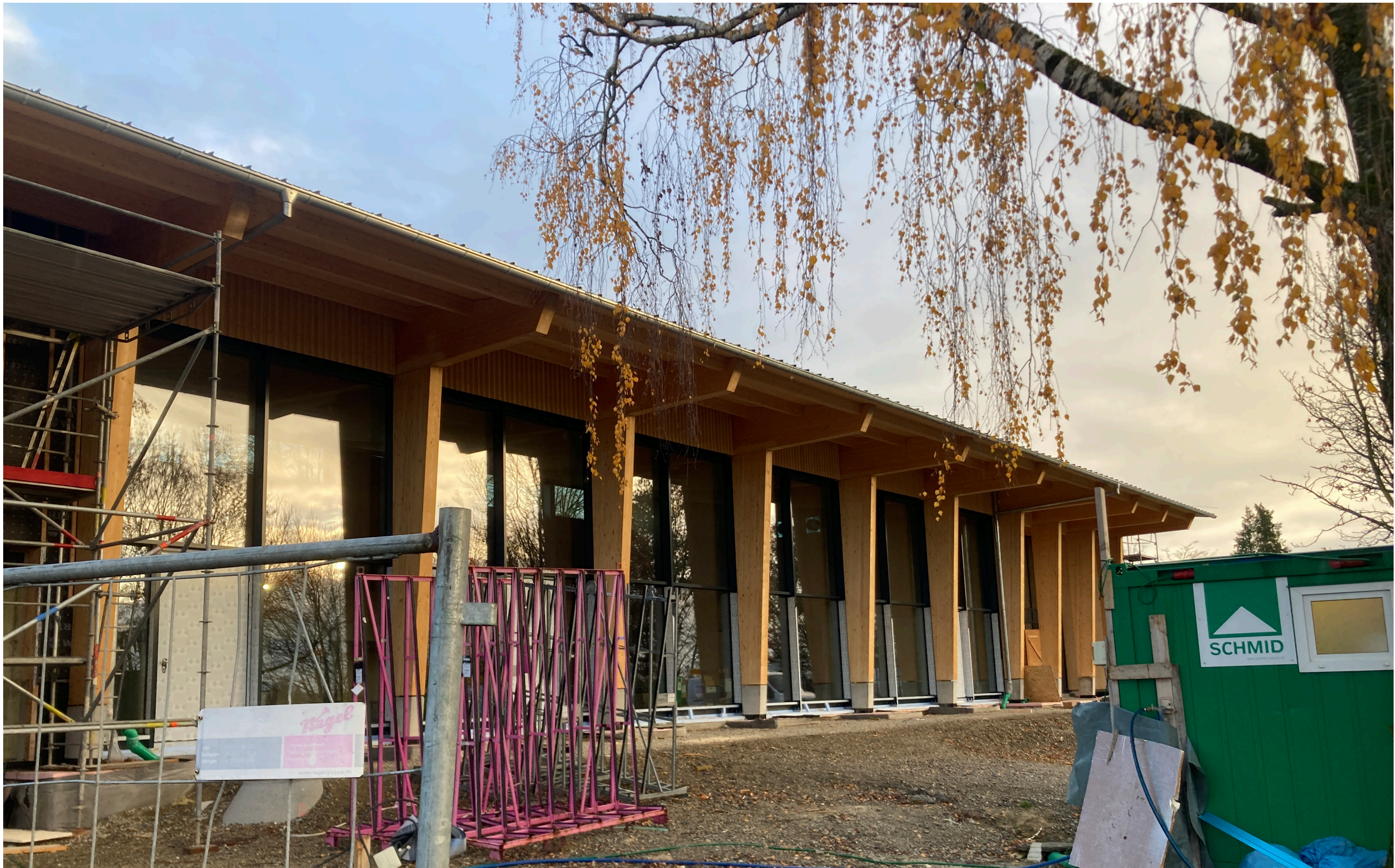
Südfassade Halle, raumhoch verglast
