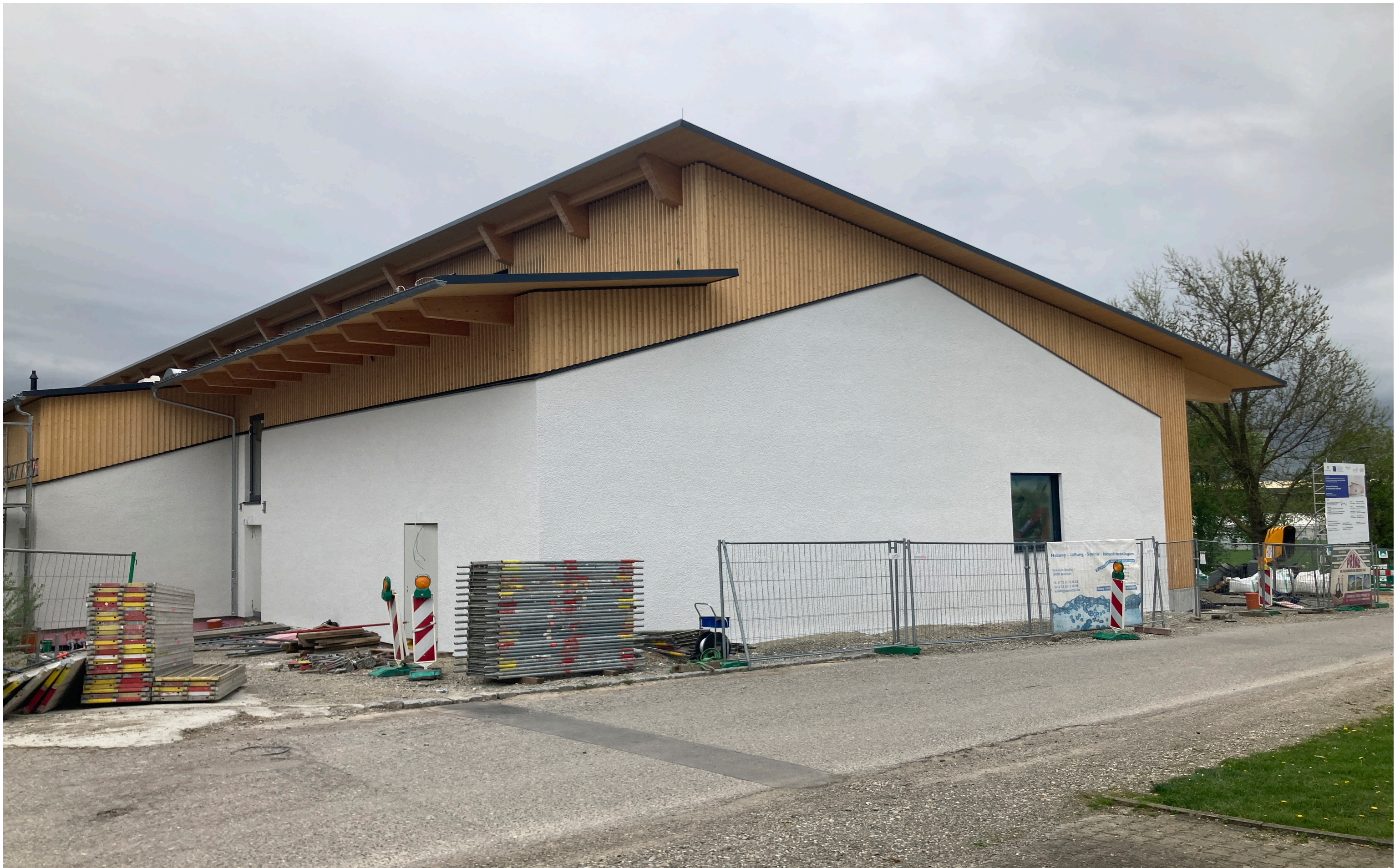
Abschluss Gebäudehülle, Abbau Gerüst
