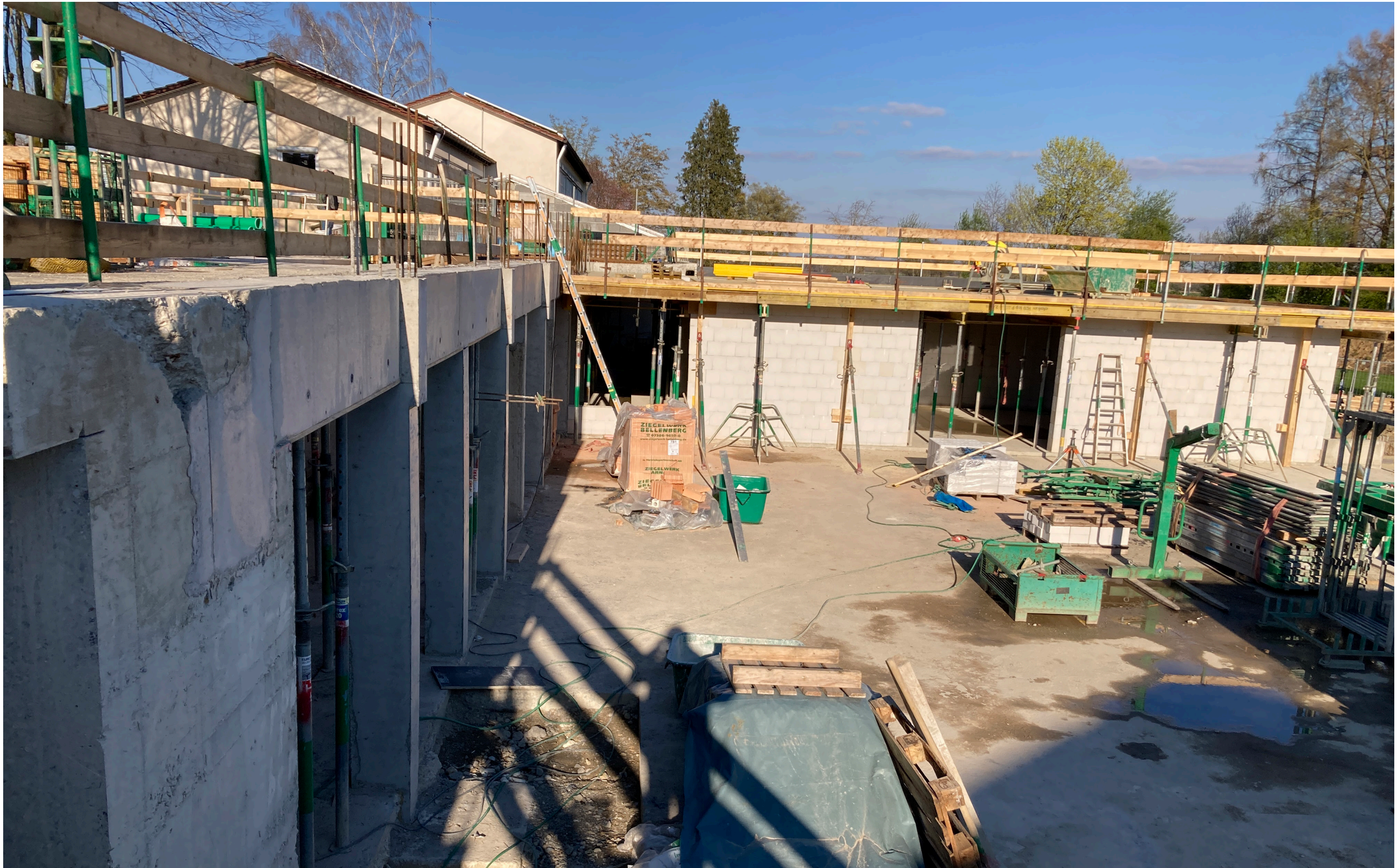
Schalungsarbeiten Decke ü.EG
